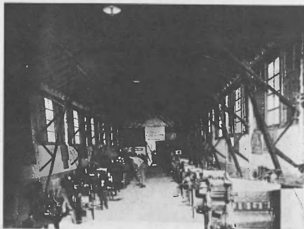
LA SALLE DE TRAVAUX FRATIQUES « AUTO »
